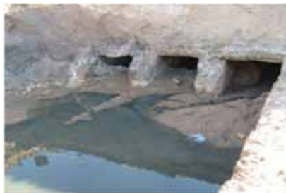
Fig. 09: Efluentes residenciais e/ou industriais lançados in natura no Rio Catú.
