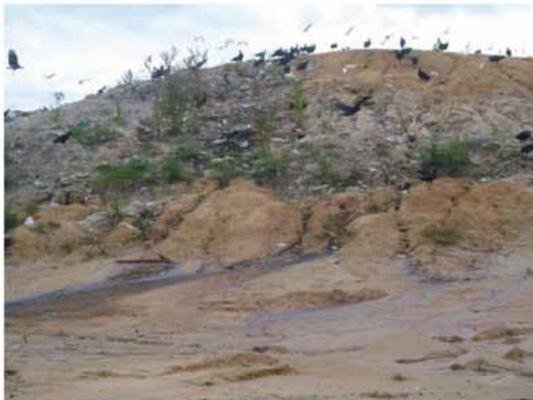
Figura 15: Chorume escoando da trincheira no “Aterro Sanitário” do Município de Horizonte.
